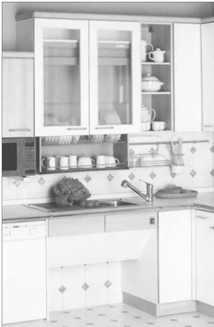
26. Detail dřezu. Na obrázku vidíme jednu z možností správného osazení a umístění dřezu v kuchyni určené pro tělesně postiženou osobu. Nad dřezem je umístěn výsuvný koš na nádobí, který slouží jak k uložení nádobí, tak k jeho osušení. Vysouvání může být buď manuální, nebo elektrické – vypínač je na čelní straně vpravo „panelu“ dřezu. Velmi důležitý je zde ochranný kryt na sifon, který při poruše těsnosti sifonu zabrání opaření nohou vozíčkáře. Povšimněme si na tomto detailu i umístění mikrovlnné trouby. Ta je zavěšená na spodní část závěsných skříněk. Toto umístění má tu výhodu, že nám nezmenší pracovní plochu kuchyně. (Zdroj: katalog firmy Koryna.)
