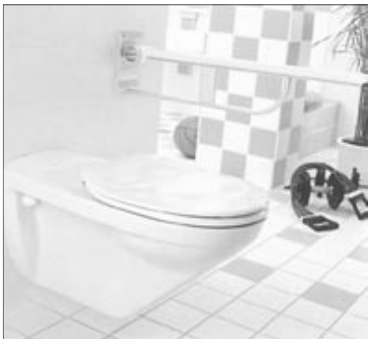
19. Nejvhodnějším typem WC mísy je konzolová mísa. Ta má dvě výhody. Zaprvé umožní osazení WC mísy přesně do požadované výšky, která jak jsem již uvedla je velmi individuální, ale neměla by být nižší než 45 a vyšší než 52 cm, a navíc umožní handicapovanému, v tomto případě vozičkáři přiblížení se k WC míse tím, že stupačky vozíku podjedou pod mísu. Tam, kde z vážných důvodů nelze použít tento typ mísy (mísu osazujeme na nenosné přičce a není tuto možné zpevnit přízdívkou, protože bychom zabrali příliš mnoho půdorysné plochy místnosti), můžeme použít „klasickou“ WC mísu. Pokud nám výškově nevyhovuje a potřebujeme ji zvednout, provedeme to tak, že podezdíme WC mísu POUZE v místě, kde je noha mísy. V žádném případě nesmíme osadit mísu na jakýsi sokl, který vyčnívá mimo půdorysnou plochu mísy. Tím bychom naopak přístup k WC míse vozičkáři, ale i osobě o berlích značně zkomplikovali, nebo zcela znemožnili. (Zdroj: katalog firmy Villeroy & Boch.)
