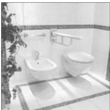
18. Na obrázku vidíme osazení WC mísy a bidetu. Vzdálenost mezi těmito dvěma zařizovacími předměty musí být 20 cm. Možností, jak osadit madla je mnoho, podle míry postižení. V tomto případě jde o osobu s postižením, která patří mezi zdatnější, a tak postačí nainstalování jednoho sklopného madla podél WC mísy a bidetu a pevné madlo za bidetem na stěně. Výška osazení madla je cca 78 cm a měla by být od sebe osově vzdálena 60 cm. Vhodná výška osazení WC mísy je 45 – 52 cm. Faktem je, že pro těžce tělesně postižené osoby je manipulace při přesedání z WC mísy na bidet dosti složitá. V těchto případech (např. v BZU) doporučuji nainstalovat vedle WC mísy sprchovou baterii, která nám poslouží tak, že k omytí po použití toalety použijeme WC mísu. Tam, kde instalujeme k WC míse navíc tuto baterii a koupelna je vybavena vanou, je třeba pod baterii nainstalovat vpust'. Vybavit WC tímto způsobem doporučuji i u hygienických zařízení, která jsou ve větších komplexech nebo ve větších stavbách občanské vybavenosti (nákupní centra, rozsáhlé obchodní domy, dopravní stavby – letiště, nádraží apod.), kde se předpokládá dlouhodobý pobyt handicapovaného. (Zdroj: katalog firmy Villeroy & Boch.)
