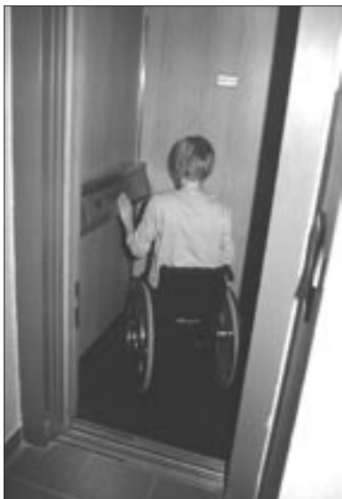
17. Vhodně vyřešený interiér výtahové kabiny, kde jsou ovládací prvky součástí madla a jsou umístěny v dosahu vozičkáře.
